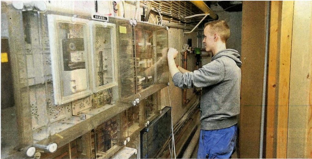
Es hakt beim Umbau: Die BBS 1 muss den Einzug in die alte Reuter-Schule verschieben.
