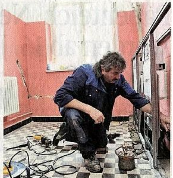
Elektronik, Sanitärbereich und vieles mehr: Die Handwerker haben noch viel zu erledigen.
