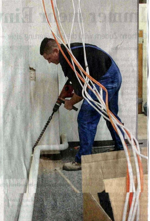
Rudolf Schulz bohrt im einstigen Lehrzimmer ein Loch zum Keller, durch das später Stromkabel zu einem Verteilerkasten führen sollen.
