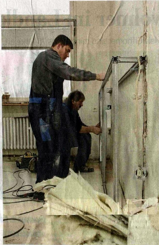
Roman Bulanow (vorne) und Andreas Scheerenberg bauen die Montagerahmen für die neue Behinderten-Toilette im Erdgeschoss auf.
